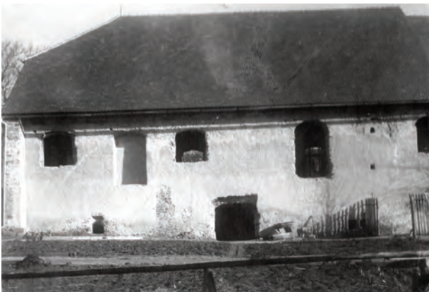
Alter Bierkeller vor dem Umbau - Ansicht von Süden
