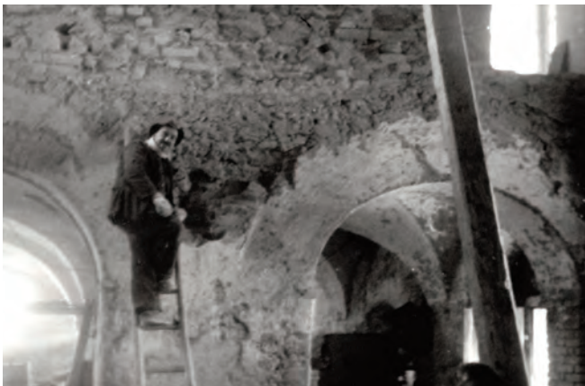
Umbau des alten Pferdestalls in eine Kapelle.
