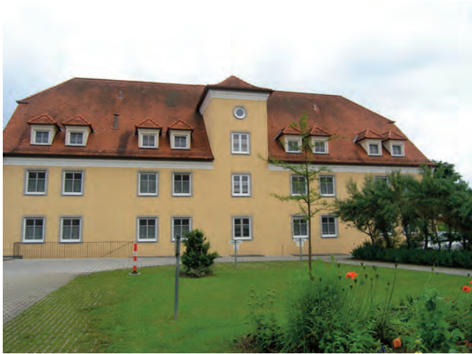
Fenstersanierung am Gästehaus Katharina 2014
