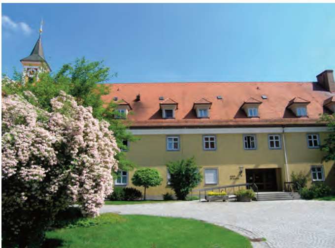
Fenstersanierung am Haus Maria 2007
